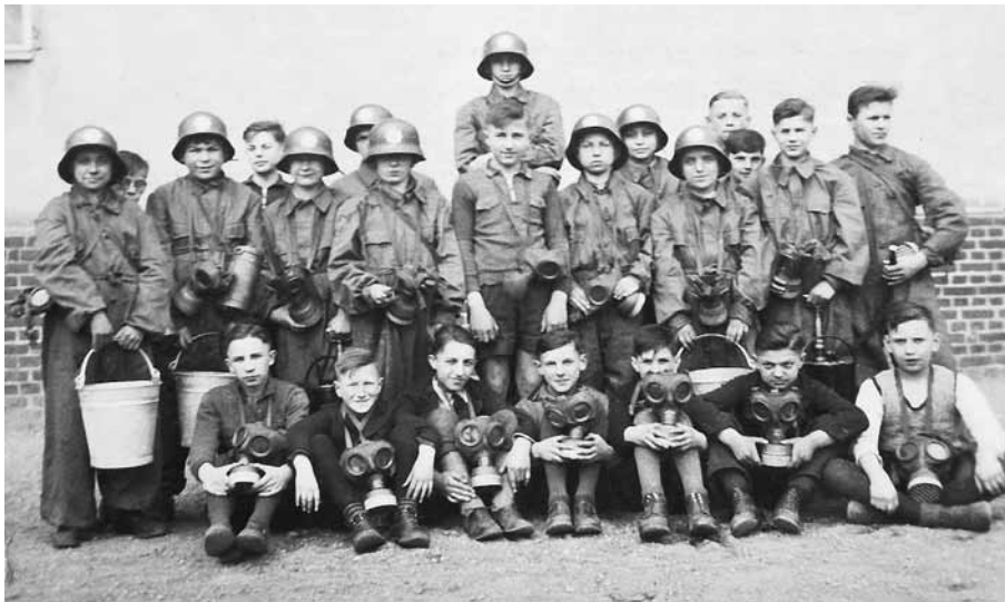
Luftschutz Rheindahlen auf dem Schulhof, stehend links Karl Heinz Lenzen, sitzend 2. von links Rudi Nießen. Geübt wurde mit Stabbrandbomben der Alliierten, die nicht explodiert waren, sowohl auf dem Schulhof als auch auf dem Speicher der Schule.
