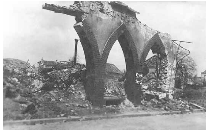
Die Löwenapotheke auf der Plektrudisstraße wurde vollständig zerstört.
