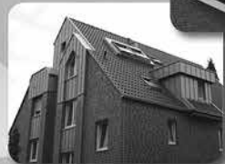
Klempner- und Fassadenarbeiten
