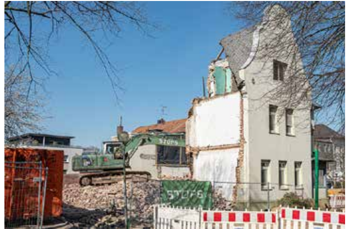
Abbruch des alten Pfarrhauses neben St. Helena April 2020
