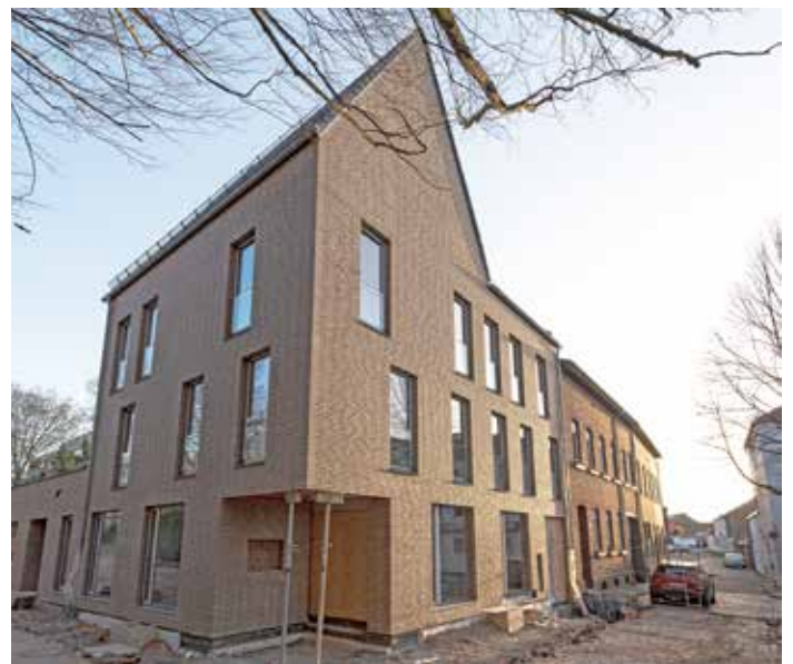
Drei Zugänge zum neuen Pfarrhaus: in der Mitte Eingang zum Pfarrbüro, links hinten Zugang zum Singesaal und rechts hinten Eingang zu den Wohnungen und Büros in der 1. und 2. Etage
