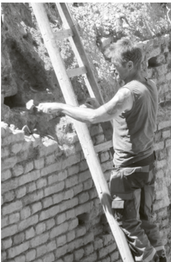
Archäologe Jürgen Kahler beim Freilegen eines Balkenlochs.
