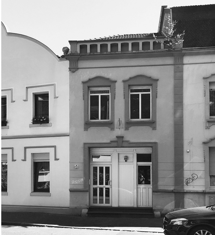
Auf der Beecker Straße 51 ist der Reha-Verein untergebracht.
