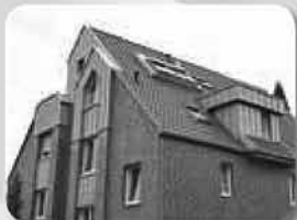
Klempner- und Fassadenarbeiten
