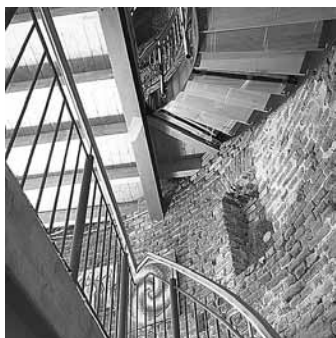
2 Geschosse sind fertig
