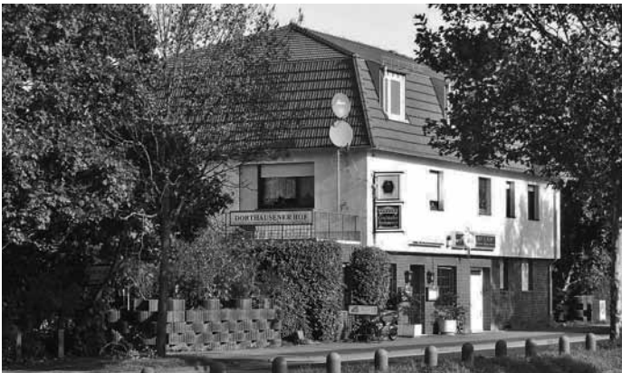
Der Dorthausener Hof nach der Renovierung im Jahre 2014.
