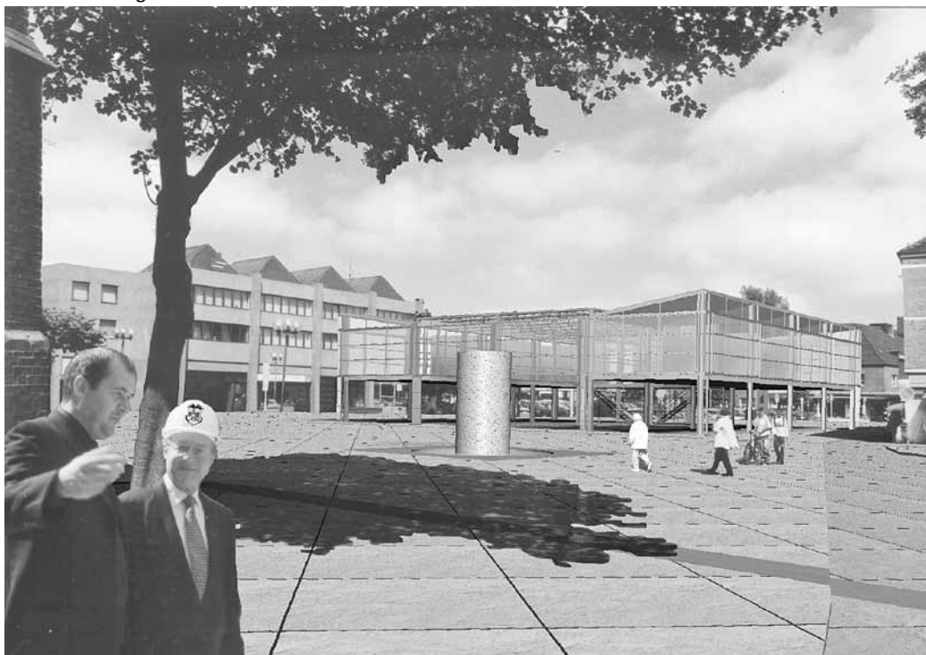
Unten der Plan des Architekten Hartmann, der eine Stahl-Glas-Konstruktion auf der Tiefgarage vorsieht. Das Untergeschoss kann durch hochziehbare Wände geöffnet und so z.B. für einen überdachten Wochenmarkt genutzt werden.
