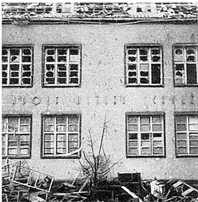
Zerstörungen an der Adolf-Hitler-Schule (Hauptverbandsplatz) auf der Howahrde Straße, heute Körperbehindertenschule Max-Reger-Straße
