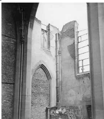
Chor der Pfarrkirche St. Helena mit den Zerstörungen
