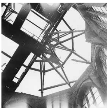
Zerstörtes Chor von St. Helena
