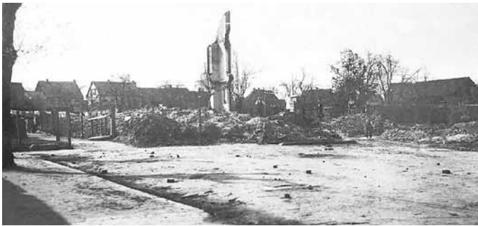
Rund um den Marktplatz steht fast kein Gebäude mehr, nur ein kleiner Rest des Strauß-Hauses Marktplatz 6.
