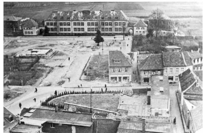
Blick vom Kirchturm auf die Plektrudisstraße und den zerstörten Teil der Straße „Am Wickrather Tor“. Im Hintergrund die Volksschule.
