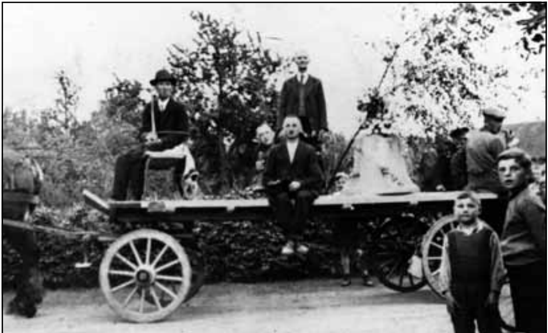
Foto unten: Die Glocke für die neue Kapelle in Mennrath wird gebracht.
