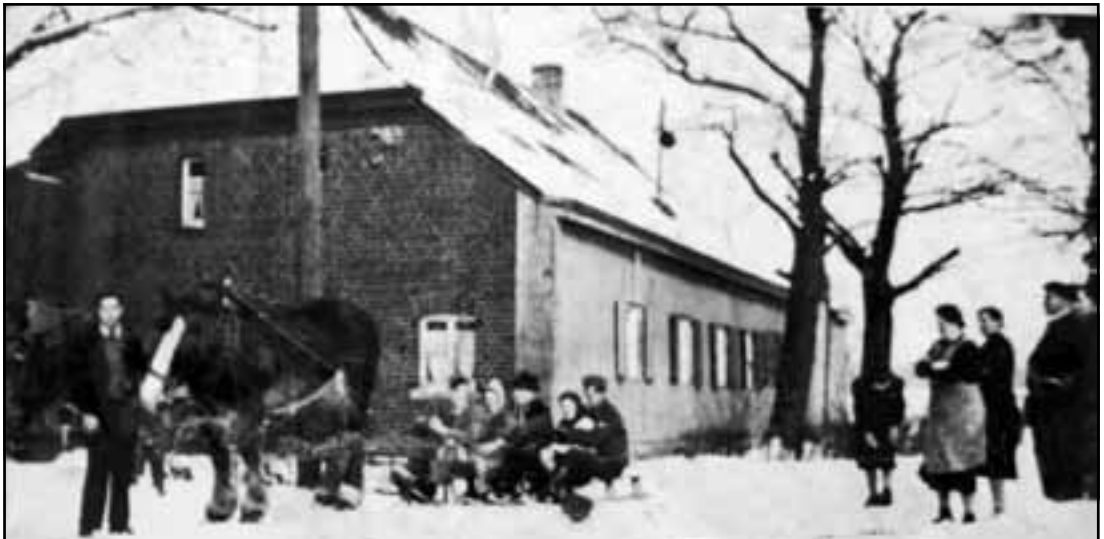
Foto unten: Viehstraße 2, heute Hausnummer 3, Bauernhof Rahmen, um 1920
