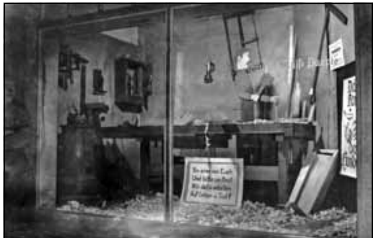
Foto rechts: Ab 1932 führte Karl Purrio sen. den Betrieb weiter. Bei einer handwerklichen Ausstellung in den 1930er Jahren wurde das Schaufenster am Mühlentor 15 so dekoriert, wie es auf dem Foto zu sehen ist.
