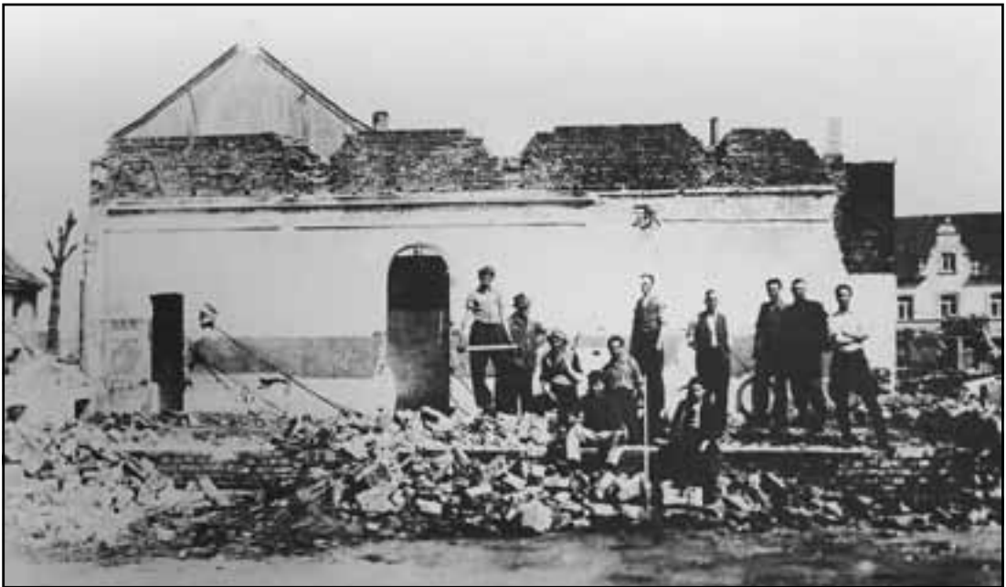
Foto unten: Der Pflaum Saal war nach dem Bombenangriff vom 25.02.1945 zerstört. Im Saal kamen viele Fremdarbeiter ums Leben. Das Foto zeigt Aufräumarbeiten am Saal. Heute steht dort das Wohnhaus Kleiner Driesch 5.
