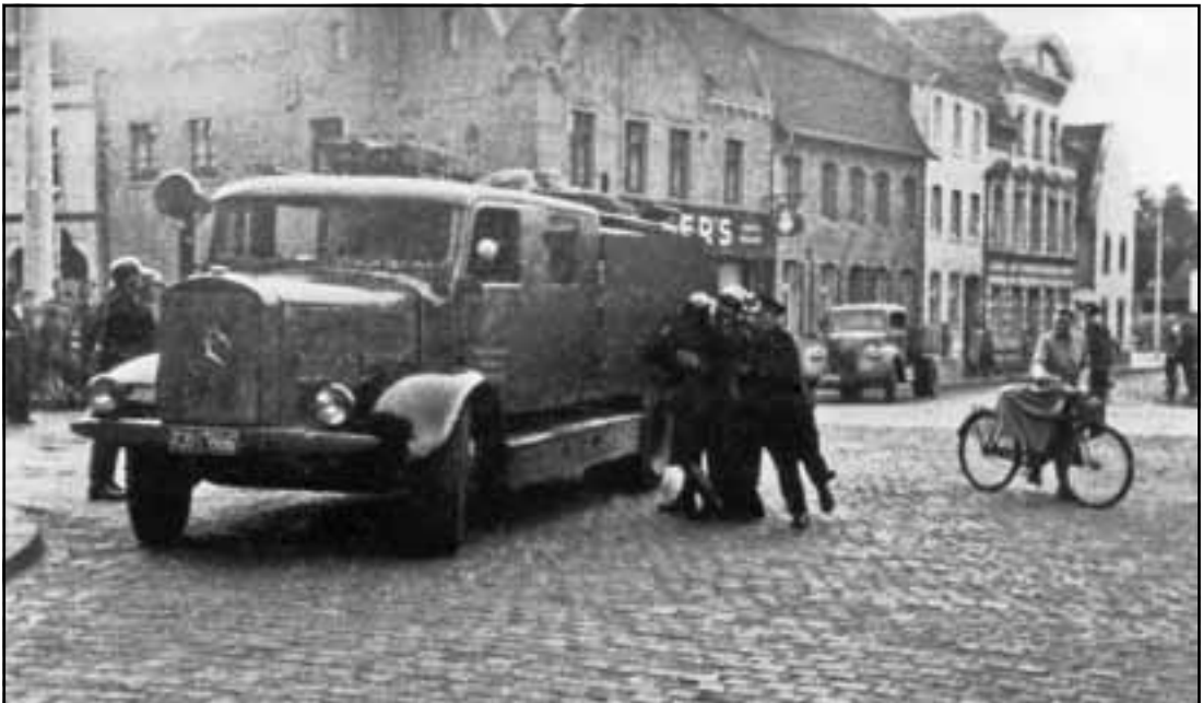
Foto unten: Freiwillige Feuerwehr Rheindahlen bei einer Übung vor der Kirche, um 1948. Geradeaus die Straße Am Mühlentor, dort ist heute der Parkplatz, links geht es in die Becker Straße.
