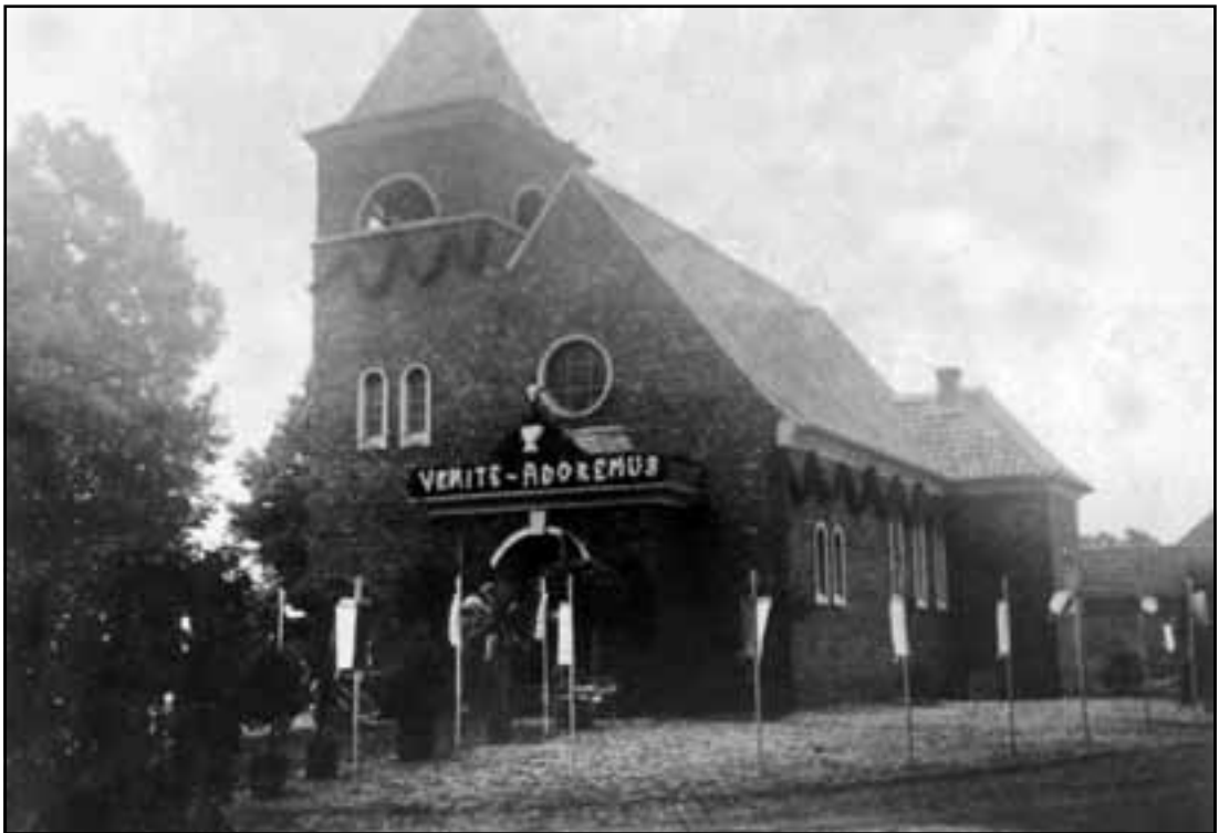
Foto oben: Mit dem Bau der neuen Kapelle wurde sofort nach dem Abriss begonnen. Sie wurde am 15. August 1937 eingeweiht.
