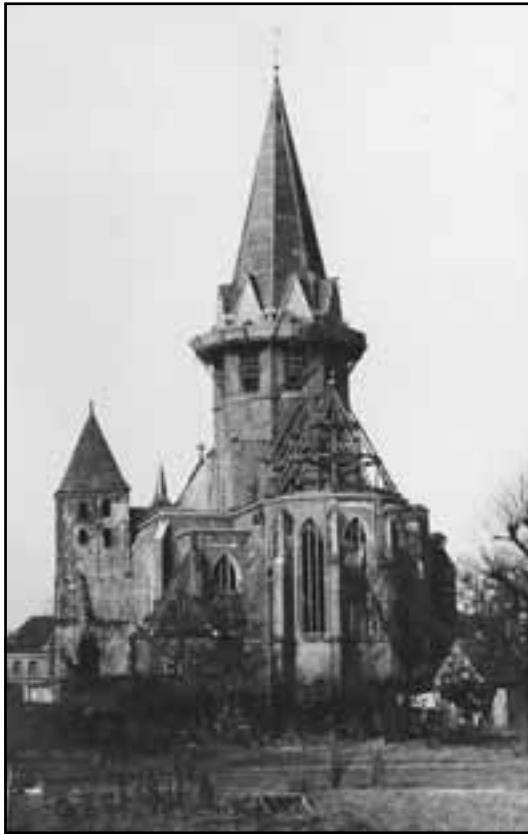
Foto links: Die Schäden des Krieges an der Pfarrkirche St. Helena waren erheblich und die Arbeiten nahmen einige Zeit in Anspruch.
