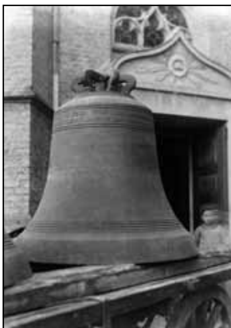
Glockenweihe in St. Helena Rheindahlen am 23. Juni 1912. Geweiht wurden die Dreifaltigkeitsglocke, die St. Helena-Glocke, die Herz-Jesu-Glocke, die St. Marien-Glocke, die St. Michael- und die Donatus-Glocke.
