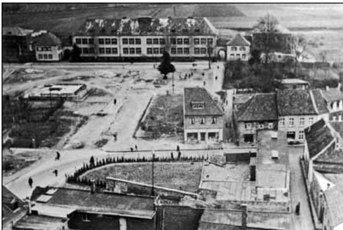
Foto unten: Ende 1945 hat sich das Bild fast völlig verändert. Das einzige Gebäude, das noch einigermaßen unbeschädigt aussah, war die Schule.
