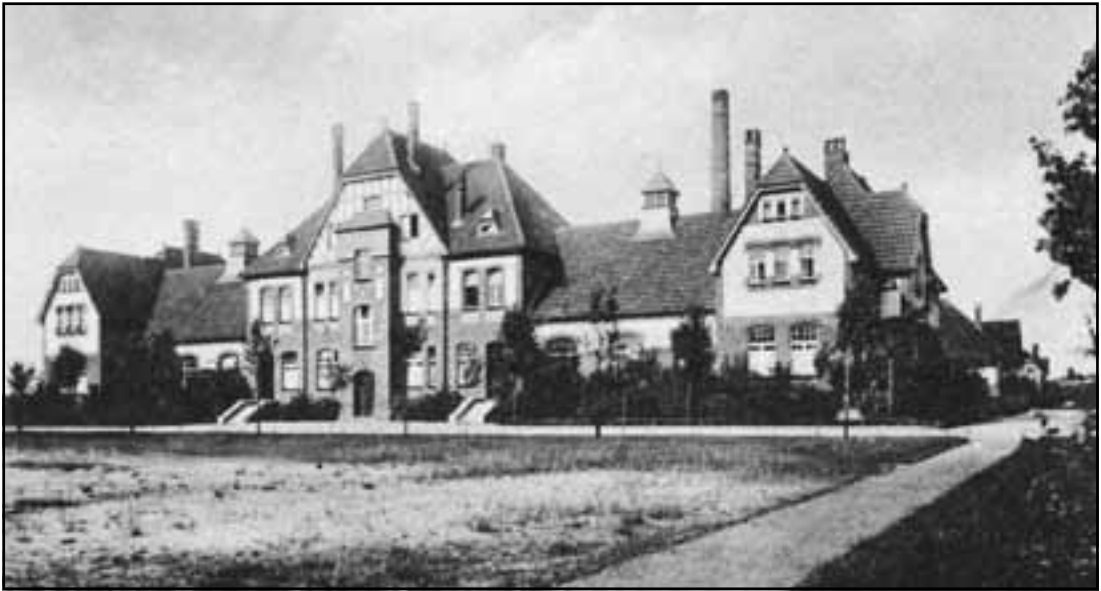
Foto oben: Wirtschaftsgebäude der Rheinischen Provinzial- Fürsorge- und Erziehungsanstalt
