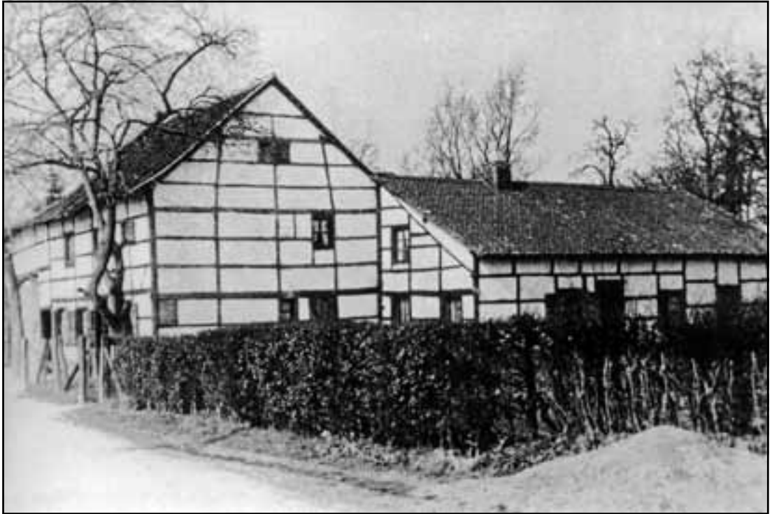
Foto oben: Viehstraße 39, im Jahre 1927, ehemalige Landwirtschaft Jökes. Der Anbau steht heute nicht mehr. Kinder haben dort mit Feuer gespielt und er ist daraufhin vollständig abgebrannt.
